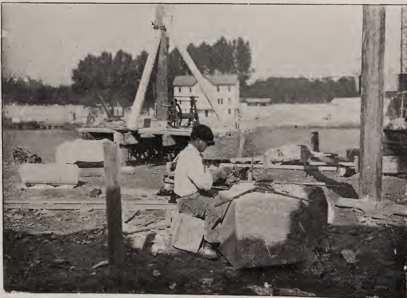
LES TRAVAILLEURS DE L'EXPOSITION. — Taille d'un bloc de granit, pont Alexandre (rive gauche).
